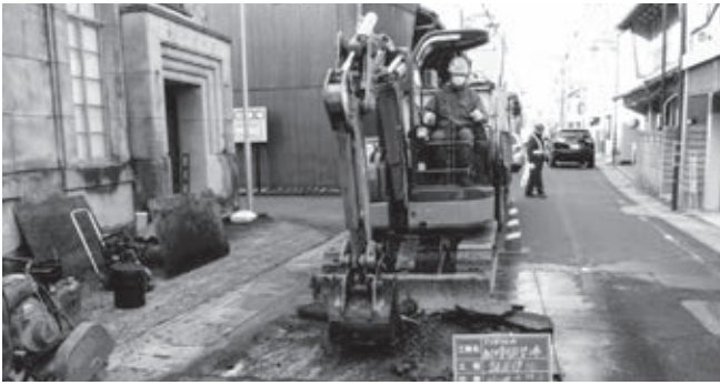
布設替工事 増屋町地内
