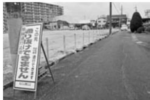
県営北方住宅解体工事
