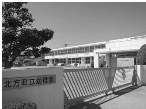
改修される町立幼稚園
