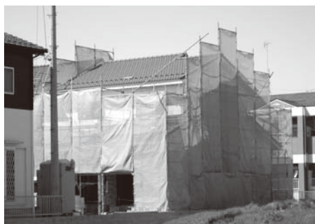
建設中の住宅
