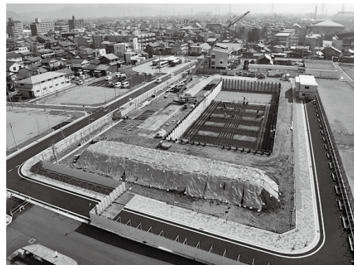
基礎工事の様子
